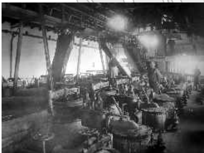
Wnętrze przetworni Kleniewskich
