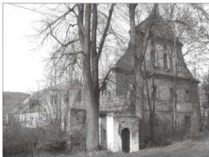
Ruina domu handlowego kupca Volkmera
