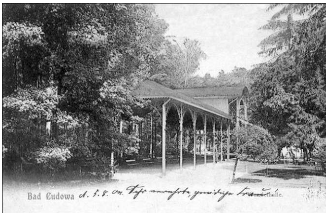
Hala spacerowa (Teatr Pod Blachą) - Kudowa -Zdrój
