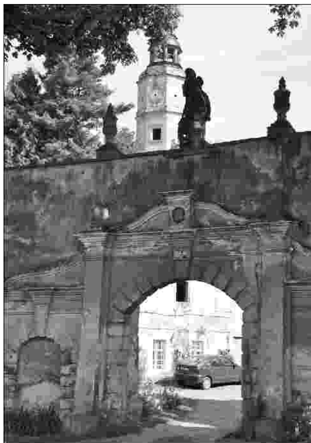
Brama wjazdowa do pałacu w Gorzanowie
