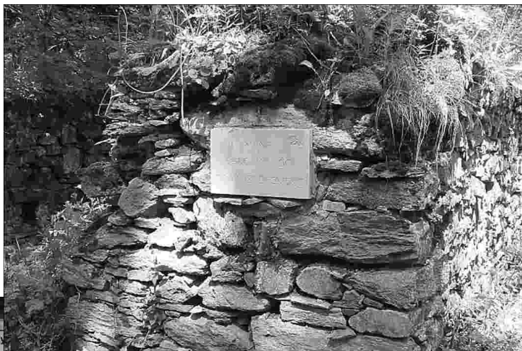
Ruina domu sudeckiego
