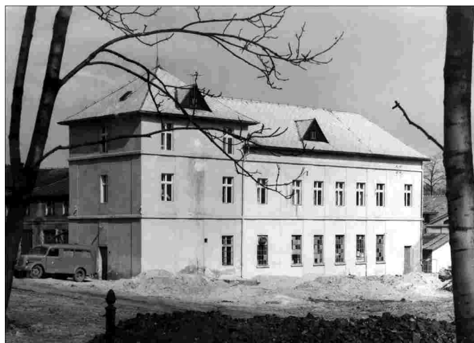
Pralnia zdrojowa i magazyny zaopatrzenia po remoncie 1968 r. ul. Warszawska
