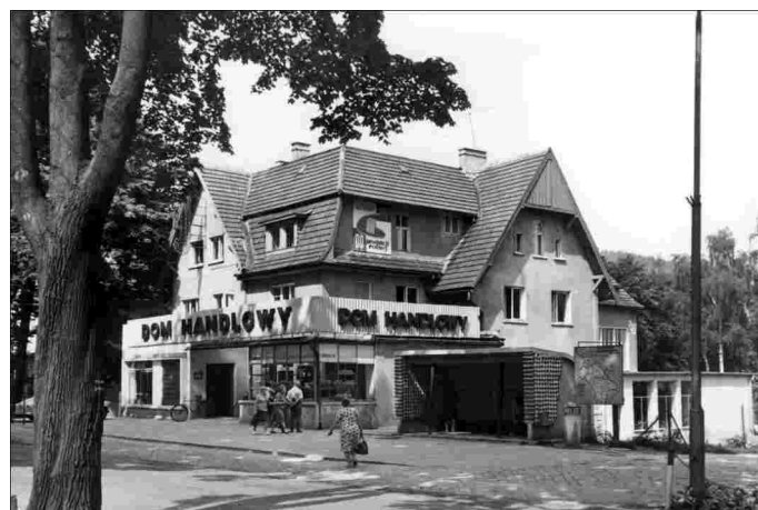
GS już z Domem Handlowym (jeszcze wewnątrz) 1963 r.
