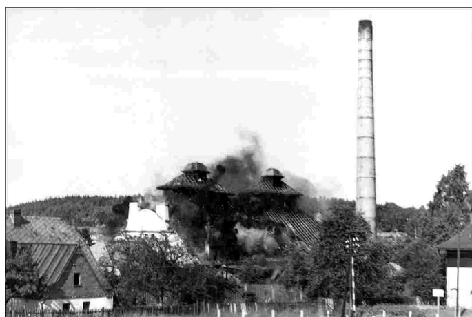
Przebudowa huty szkła 1966 r.
