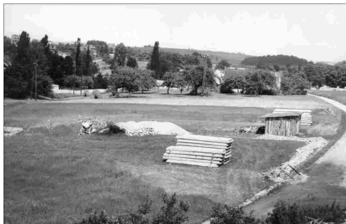
Powstają domy ul. Prusa 14 i 18 1970 r.
