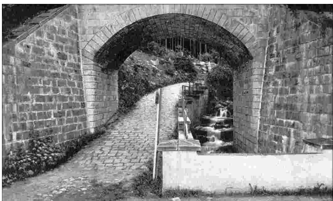
Most kolejowy nad potokiem "Rogozimiec"
